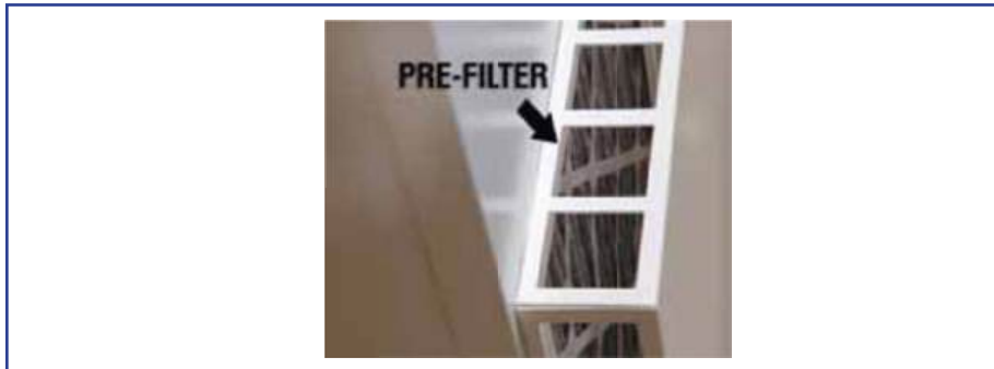
شکل ۲۴- ایجاد پرز بر روی فیلتر اولیه (پیش فیلتر) دستگاه هپا قابل جابجایی
